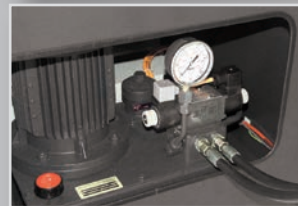
Zweikreis hydraulikaggregat im Schrankunterbau
